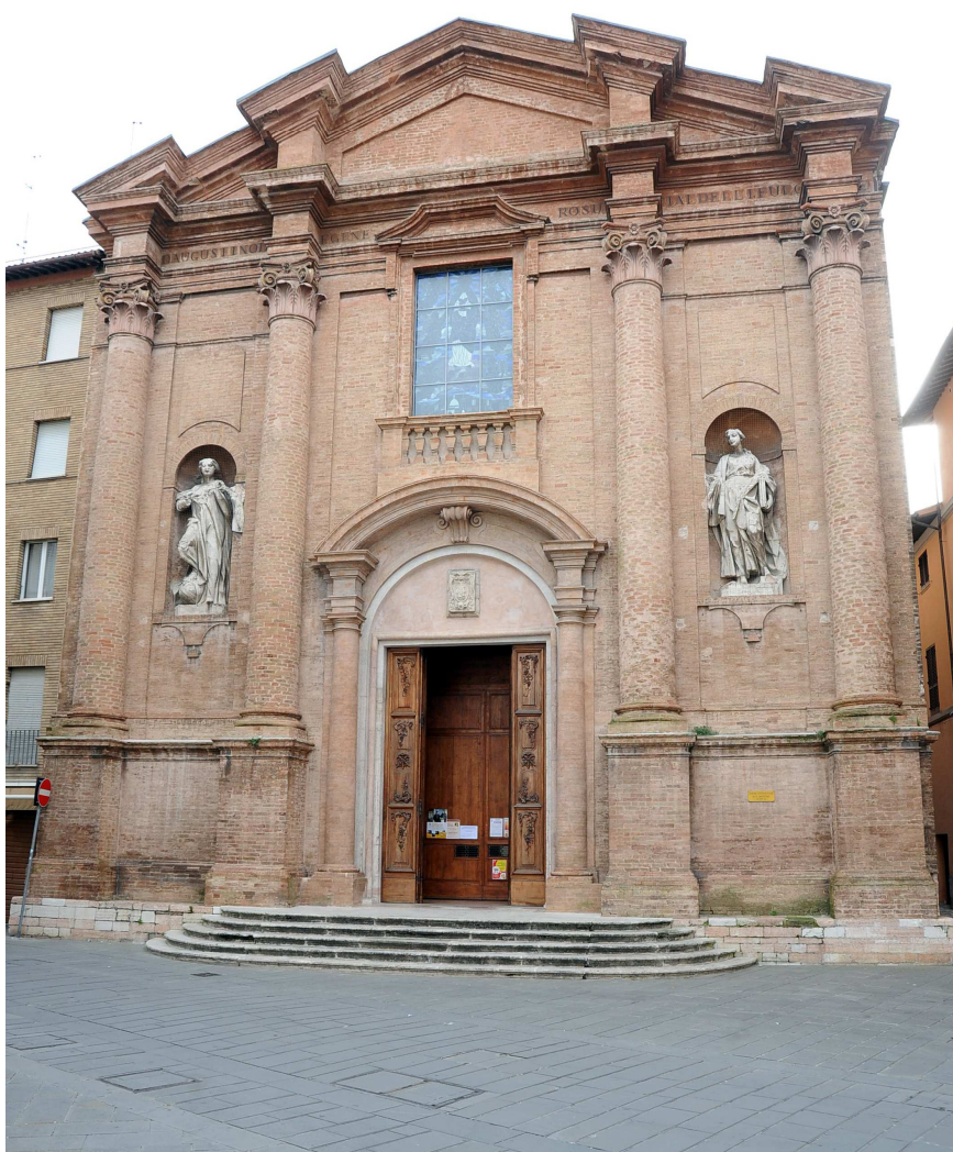
Prospetto della Chiesa di S. Agostino - Pro Cattedrale Piazza Garibaldi - Foligno
